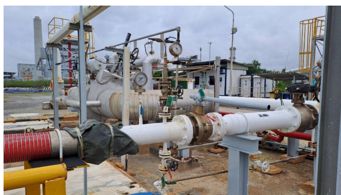
รูปที่ 2-32 การติดตั้ง Block Valve ควบคุม
