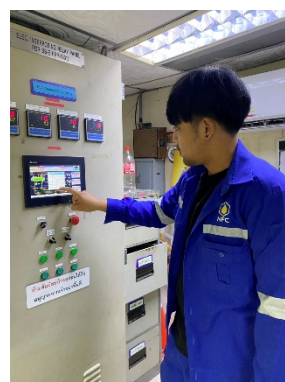
รูปที่ 2-33 ระบบ Ammonia Gas Detector
