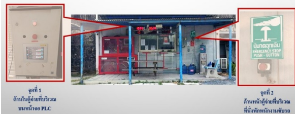
รูปที่ 2-34 ระบบหยุด/ตัดระบบแบบอัตโนมัติ
