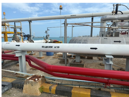
รูปที่ 2-31 การติดตั้งป้าย สัญลักษณ์และข้อความเตือนต่าง ๆ บริเวณแนวท่อขนส่งกรดซัลฟูริกและแอมโมเนีย
