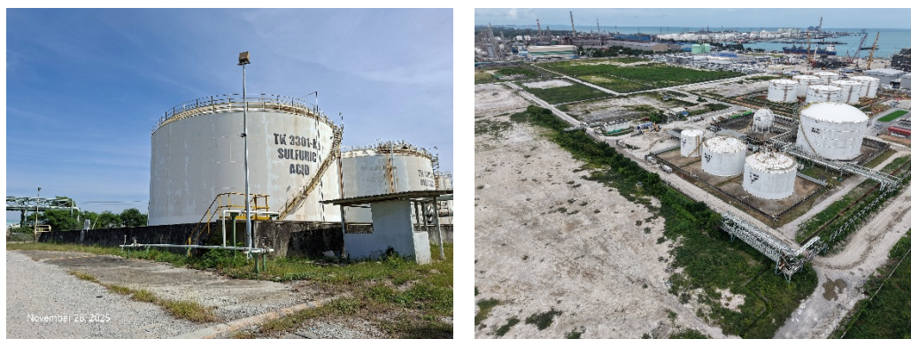
รูปที่ 2-28 คั่นกันคอนกรีตโดยรอบถังเก็บกรดซัลฟูริก
