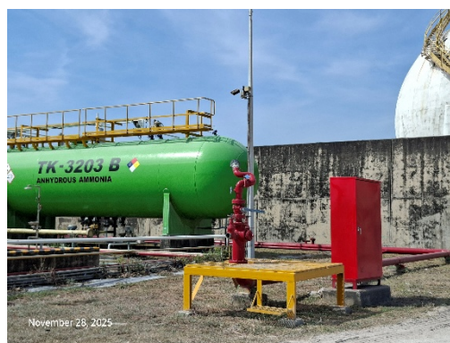
รูปที่ 2-20 ระบบป้องกันและระงับอัคคีภัยภายในโครงการ
