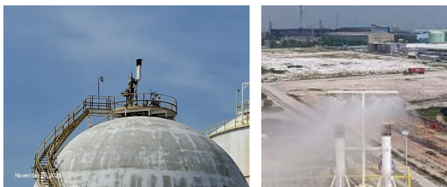
รูปที่ 2-27 การติดตั้งม่านน้ำและคั่นกันคอนกรีตโดยรอบถังเก็บแอมโมเนีย
